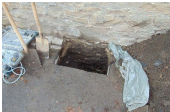
Abbildung 5 Schurf am Stützwandfuß
