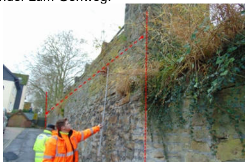
Abbildung 2 Teilbauwerk 2 oberer Wandteil mit Aufmauerung, im Bauwerksbuch Segment 4
